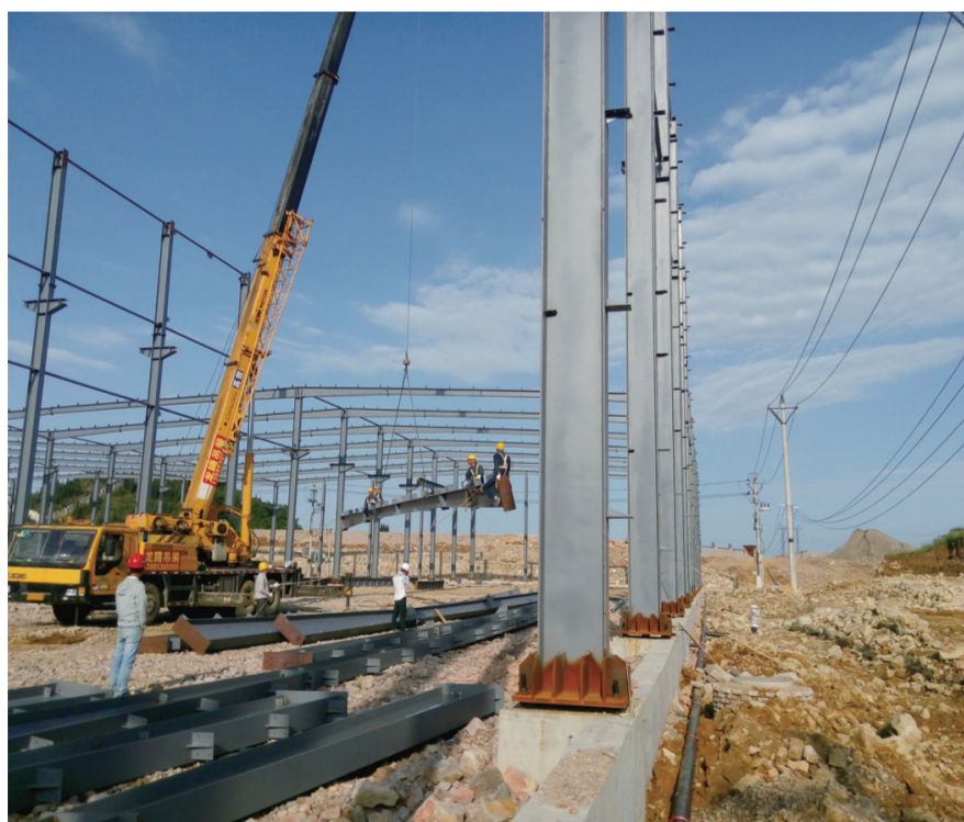
图为施工现场 □记者 田歌 摄
