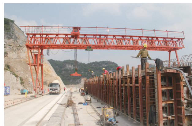
安紫高速建设现场
