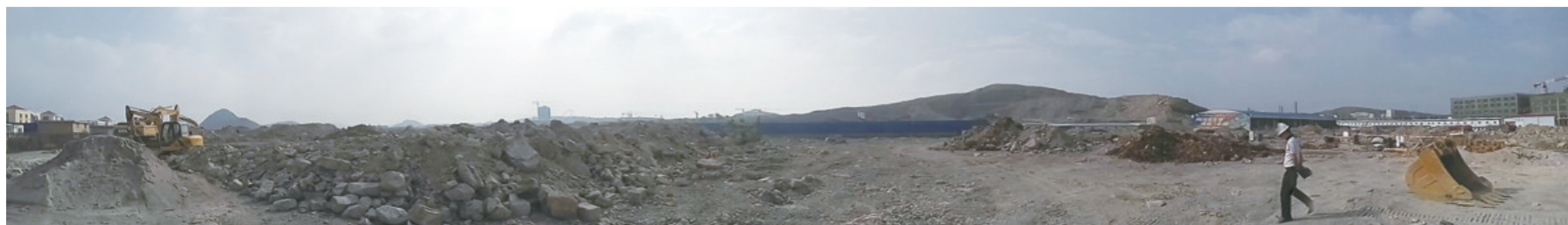
安顺豪德电商产业园区分拣物流仓储基地施工全景图
