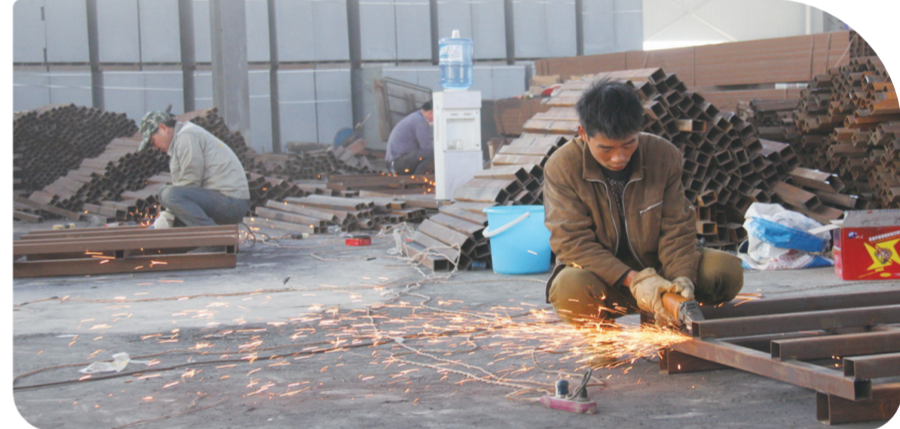
富民新型建材有限公司工人忙碌作业
