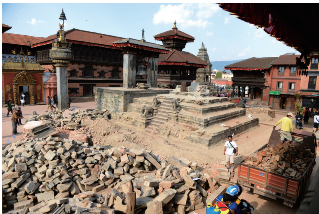
这张5月3日拍摄的照片显示，尼泊尔巴德岗杜巴广场瓦斯塔拉杜神庙完全坍塌，仅剩底座。
