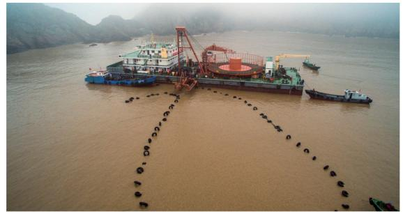
3月16日,最后400多米的海缆从"建缆一号"海 缆敷设船上缓缓放入海中,通过充气轮胎浮在海面 上,然后由小船拉上登陆点。
