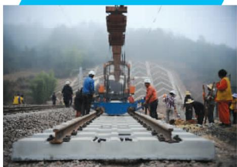
12月4日,中铁六局施工人员操作铺架设备将轨排放在路基上。
