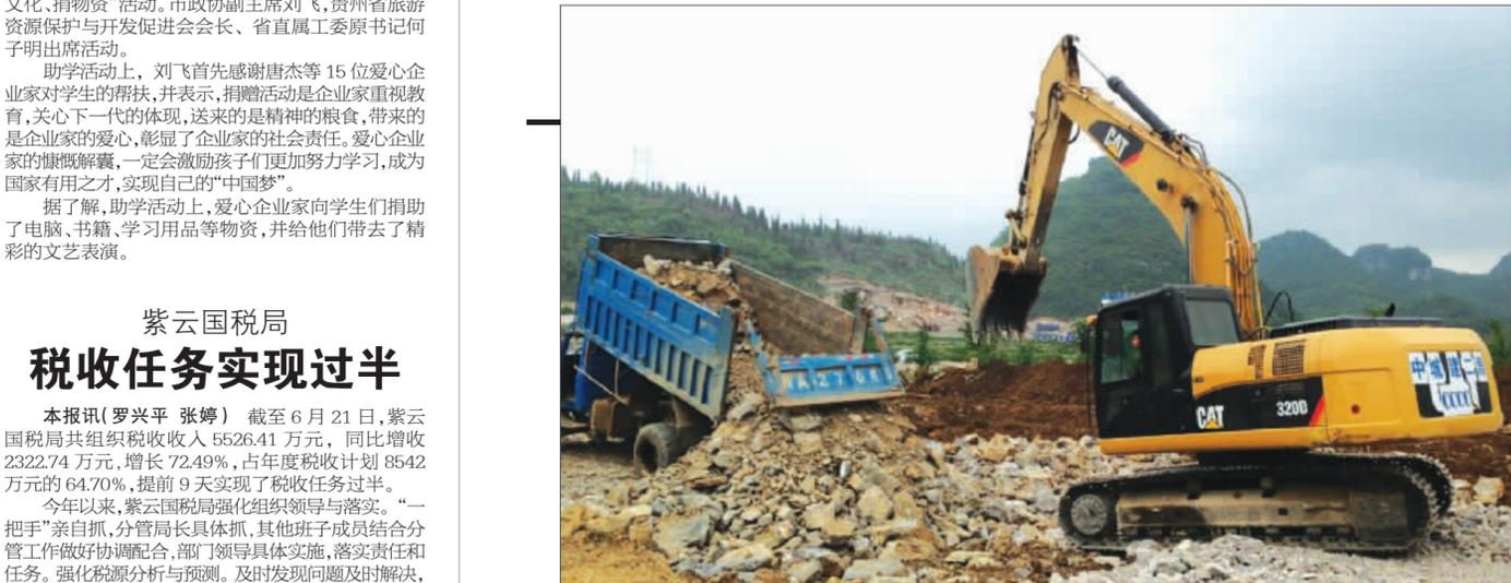
黄果树旅游商品加工博览园园区主干道网路建设项目建设顺利推进。该道路全长1.9公里,路基宽40米,工程总投资9600万元,现工程路基主体及管网埋设已基本完成,三座桥梁浇筑完成60%,工程已完成投资6300万元,完成投资形象进度70%,预计今年年内实现通车。 □记者 王思源 摄
