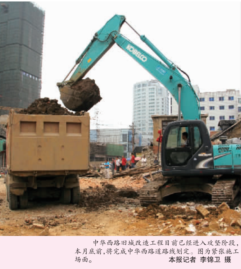
中华西路旧城改造工程目前已经进入攻坚阶段,本月底前,将完成中华西路道路线划定。图为紧张施工场面。
