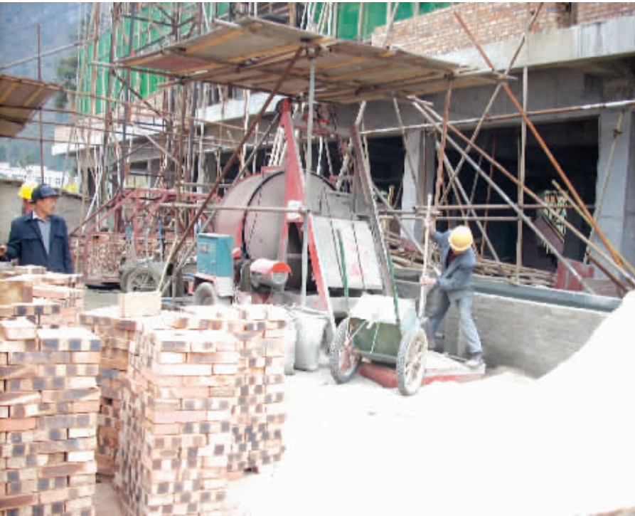
紫云自治县总投资500万元,总建筑面积为4000平方米的第四期80套廉租住房正在如火如荼建设中。据介绍,600余套的第五期廉租住房建设项目也已经完成了项目选址等相关前期工作。 本报记者 李晓康 摄
