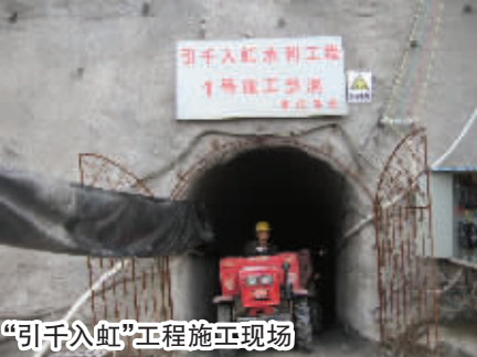
“引千入虹”工程施工现场
