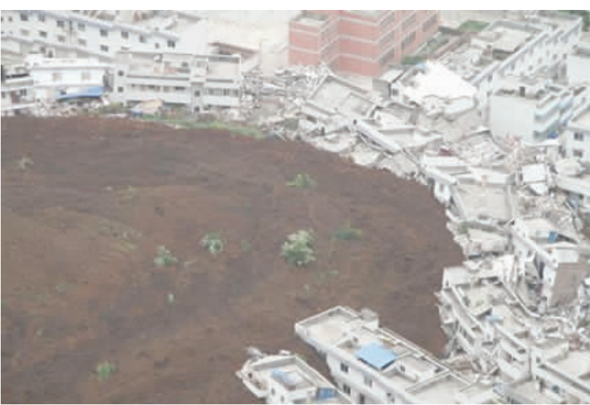
这是7月27日拍摄的滑坡现场。当日凌晨5时许,雅安市汉源县万工乡双合村一组万工集镇后山(小地名二蛮山)突发滑坡,造成万工集镇、双合村一组部分村民房屋垮塌。初步核实,截至8时30分,共有58户房屋受损,21人失踪。 据新华社
