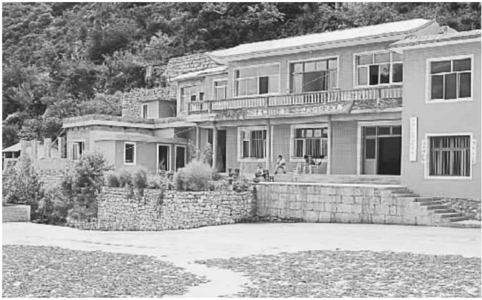
肖国昌勤劳致富后,建起了气派的新居。
